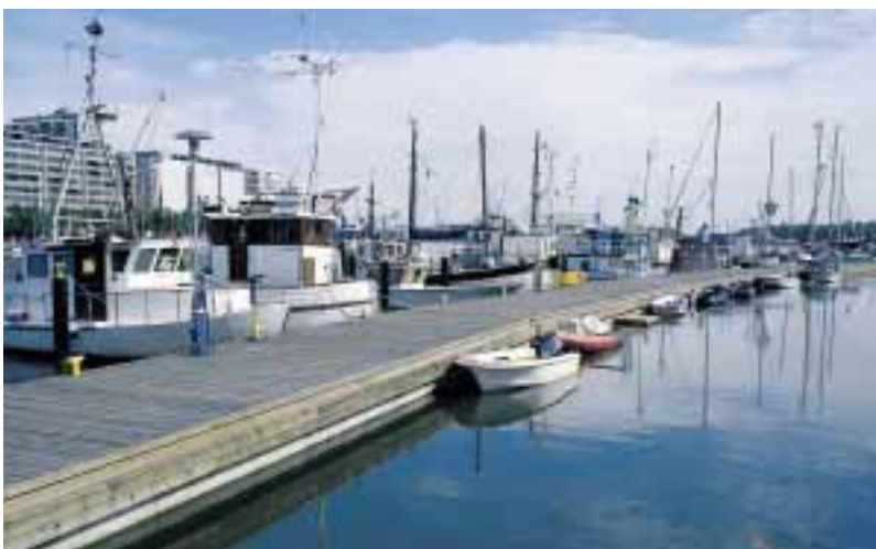
Bue formet bølgebryder 4,3 meter bred forankret med pæle, træ dæk og Rolec forsyningsstandere (Helsinki, Finland).
