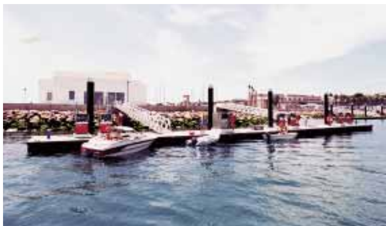
Kraftig anløbsbro forankret på rør, med trædæk og landgangsbroer (Cascais Marina, Portugal).
