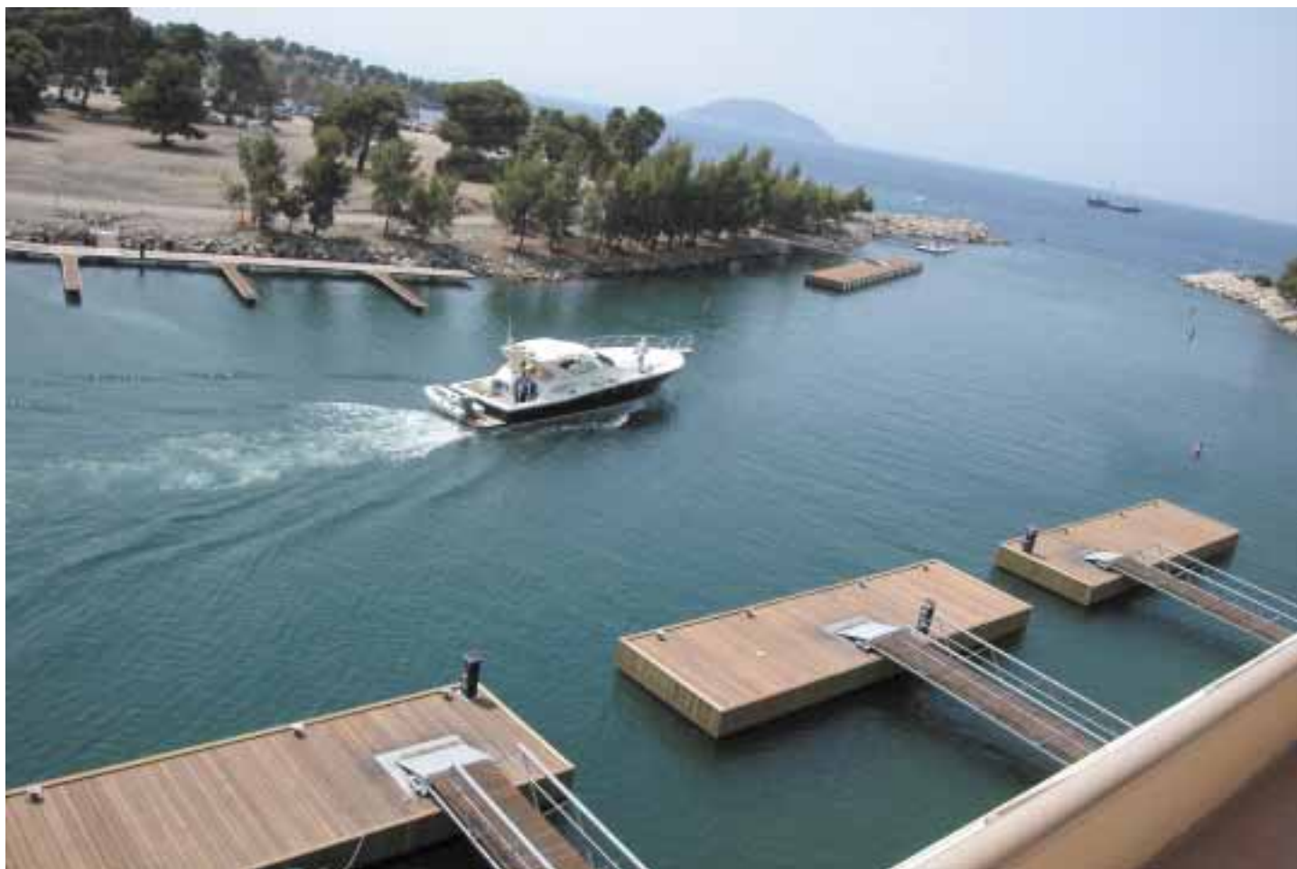
Vore anløbsbroer produceres op til 4,3 m i bredden og med en last kapacitet på 7,0 kN/m 2 med beton eller trædæk i forskellige træsorter (Porto Carras, Grækenland).
