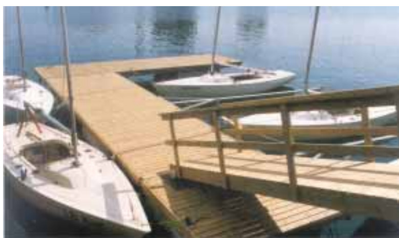
M300. Her ses en løsning til en mindre klub installeret ved Kalvebodbrygge i København.
