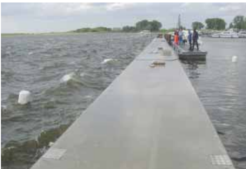
Bølgebryder 2700 med Seaflex forankring under opførelse (Rechlin, Tyskland).
