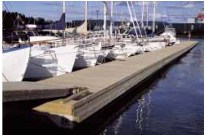
Bølgebryder 2700 med træ dæk og kæde forankring (Finland).
