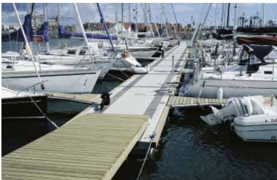
Heavy Duty seriens type 2700 med service kanaler, Seaflex forankrings system, store Y-Bomme og Tallykey forsyningsøjler (Helsinki, Finland).
