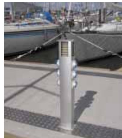
Tally Key forsyningsøjler som er udført i søvandsbestandigt aluminium.
