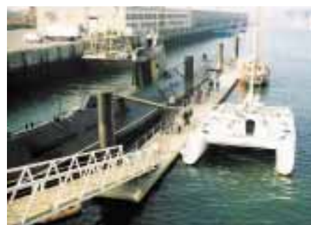
Heavy Duty serien kan forankres med Seaflex, kæder eller rør, og sammenkøbes med lange stål eller aluminiums landgange. (Zeebrugge, Belgien).
