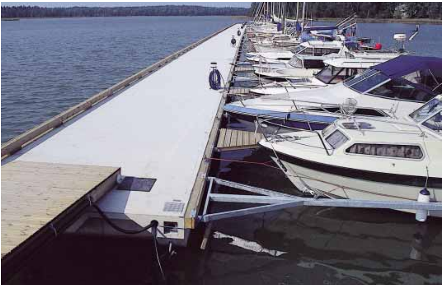
Bølgebryder 3800 med Seaflex forankring og Rolec forsyningsstandere (Espoo, Finland).
