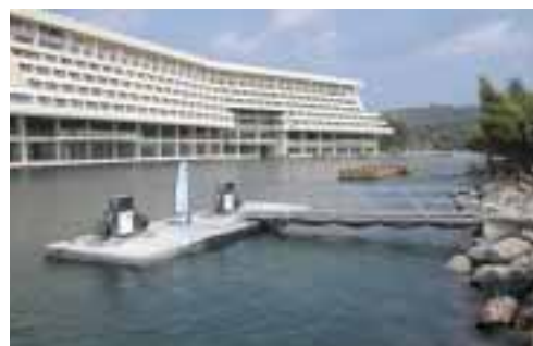
Heavy Duty bro med integreret benzin og diesel station (Poto Carras Grækenland).
