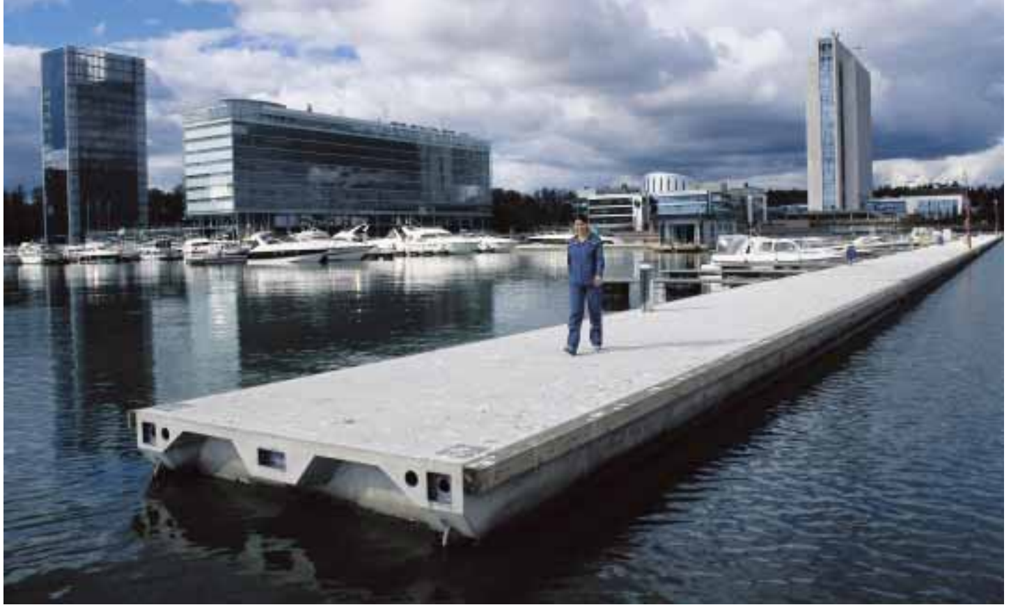
Bølgebryder 3800 med Seaflex forankring og Rolec forsyningsstandere (Finland).
