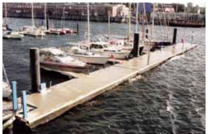
Bølgebryder 3800 med pæle forankring med aluminiums Y-Bomme (Kiel, Tyskland).
