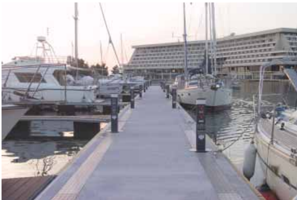
Heavy Duty serien kan monteres med service kanaler til vand og elektricitet (Porto Carras, Grækenland).
