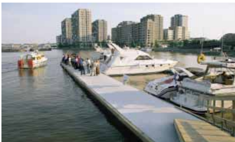
Bølgebryder type 3300 som anløbsbro (Helsinki, Finland).
